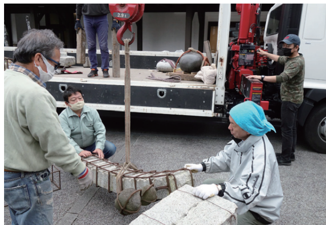
クレーン操作で微調整しながら、置く場所を決めていきます。
